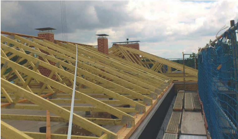
Schornsteine, Entlüftungen und Dachluken wurden in das neue Steildach mithilfe der Scandaten eingepasst.
